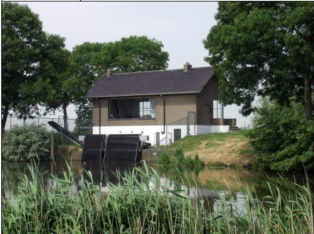
Figuur: Gemaal aan de Noordwendigedijk
