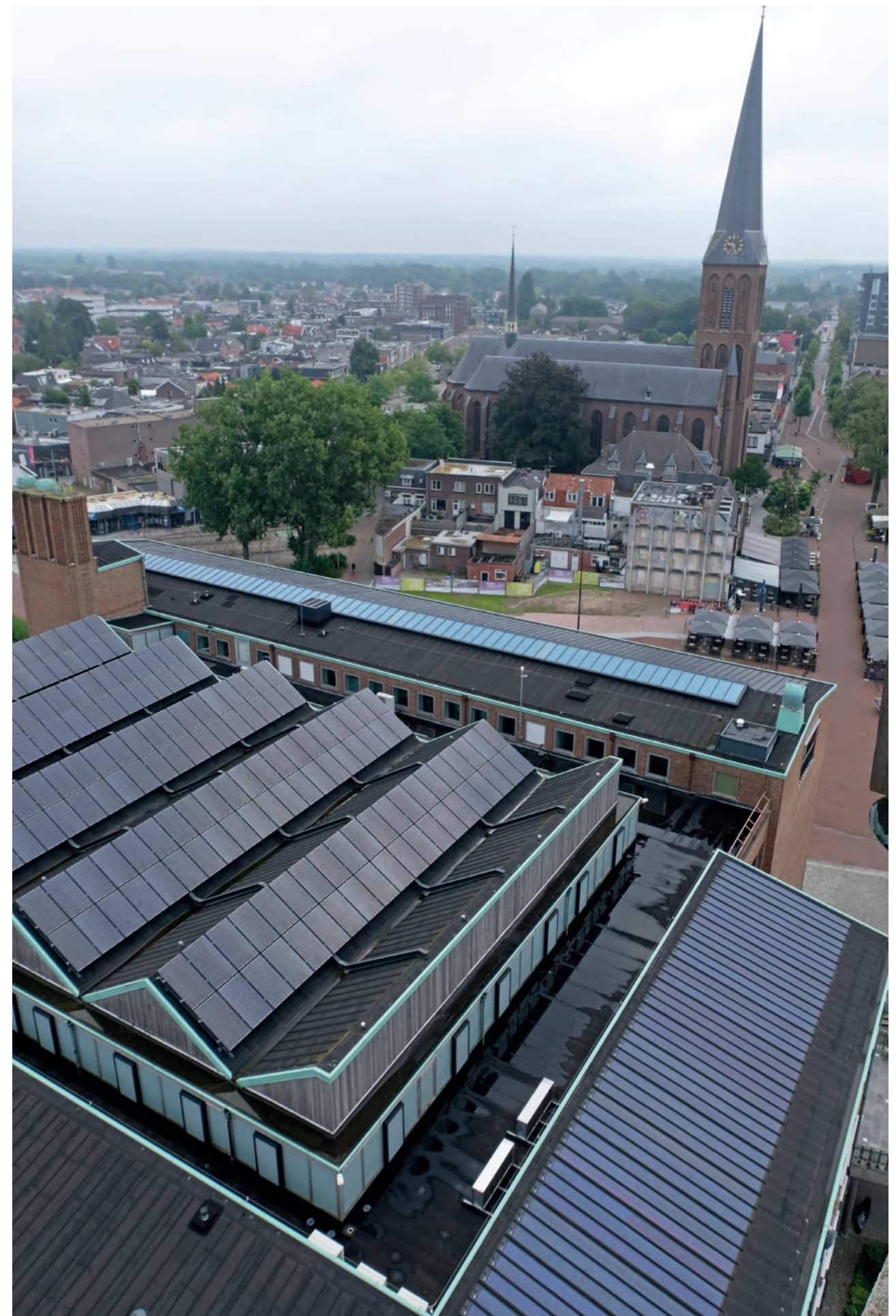
Zonnepanelen op het stadhuis
