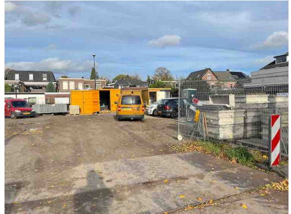
Figuur 3. Noordoostelijke deel van het plangebied met werkterrein aannemer.
