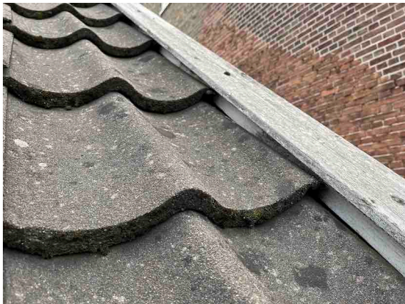
Figuur 8. Situatie dakrand tegen de windveer.
