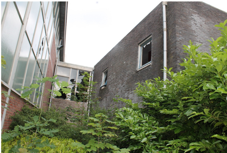
Foto verbinding tussen loods en laboratoriumgebouw
