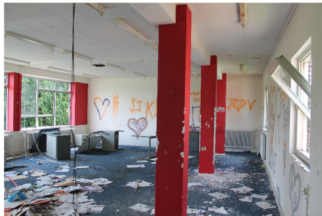
Betonstaanders op verdieping
