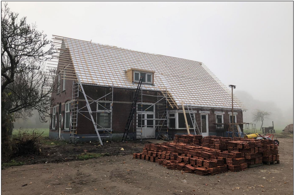
Afbeelding 3. Impressieplangebied op 23 november 2021. Woning in renovatie.
