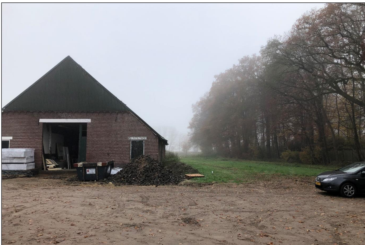
Afbeelding 4b. Impressieplangebied op 23 november 2021. Te slopen schuur voorzijde.
