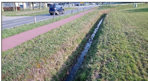
E. Sloot met geringe waterdiepte nabij open ontgraving bij kruising Boldershoekweg met Diamantstraat (4 april 2019).
