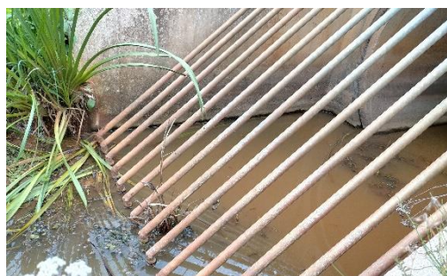
I. Riooloverstort ter hoogte van Boortorenweg in de Strootbeek
