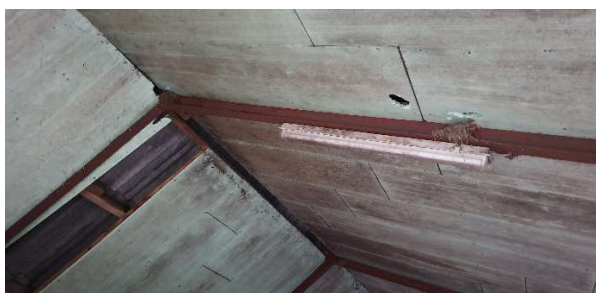
Foto 15: Isolatieplaten tegen kap jongveestal
