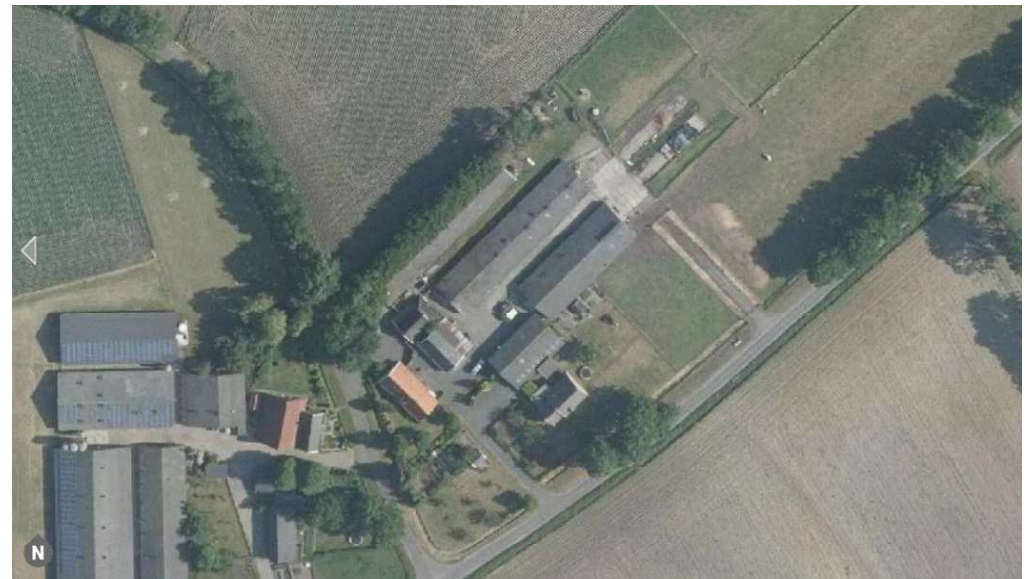
Figuur 3 Luchtfoto Stegenhoekweg
