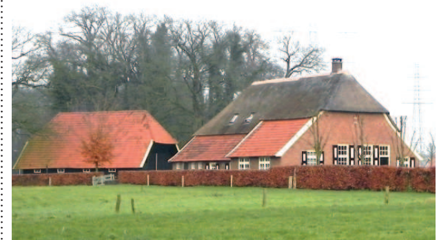
Twickelboerderij in "Twickelkleuren" en dak met wolfseinden
