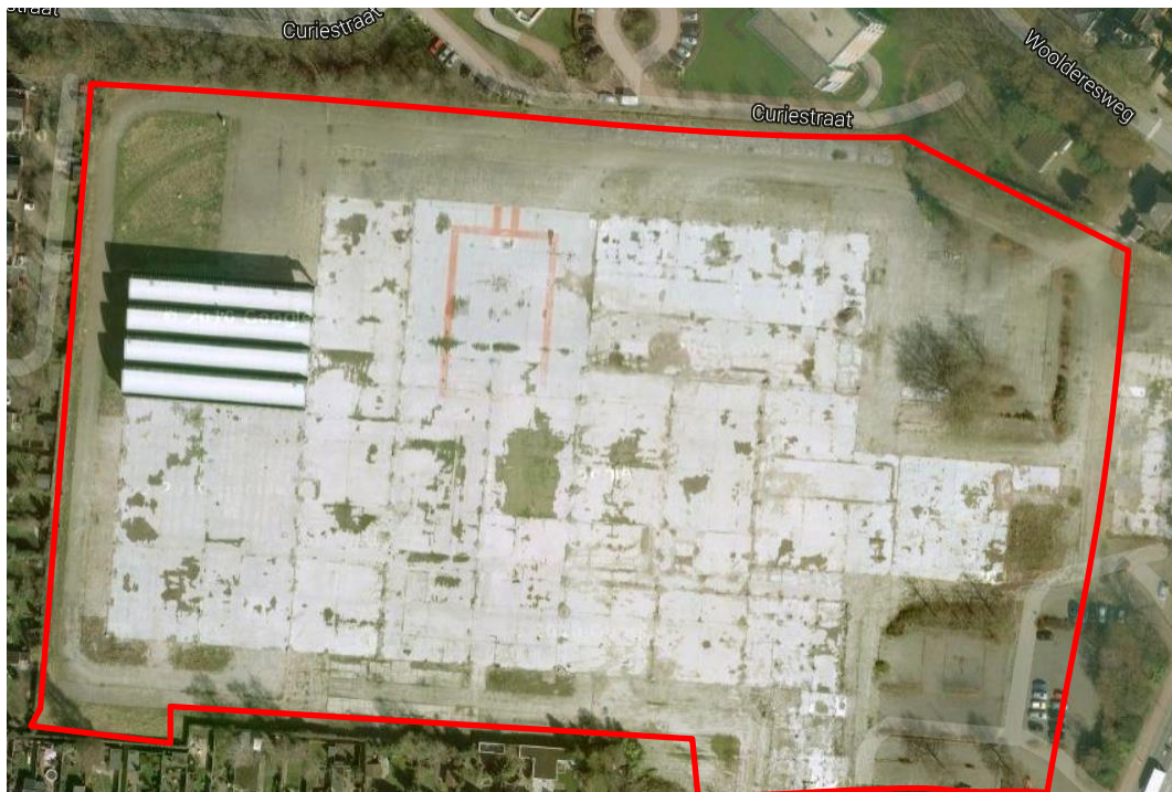
Afbeelding 3. Huidige situatie plangebied. Luchtfoto uit 2013.
