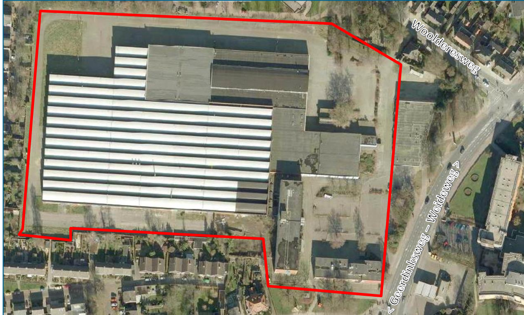
Afbeelding 2. Bebouwing voormalige Koninklijke Weefgoederen Fabriek. Luchtfoto uit 2008.
