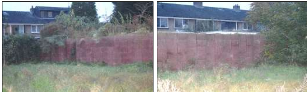
Figuur 9: foto's bestaande stenen erfafscheiding (oktober 2017)
