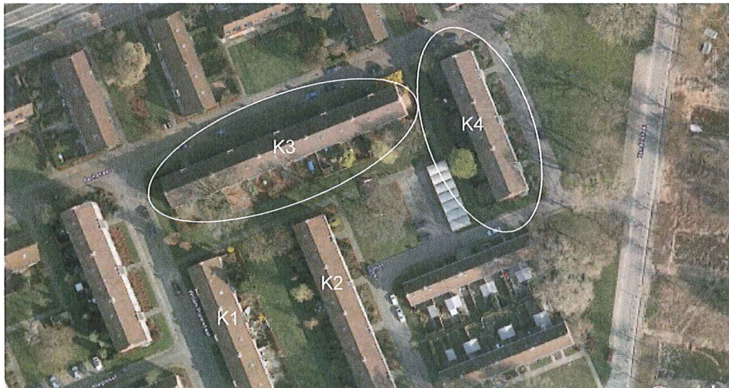
Figuur 1: Te slopen flats van de eerste fase (omcirkeld)
