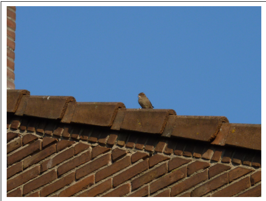
Foto 2. Huisemus maakt gebruik van de ruimte onder de dakpannen om te broeden.
