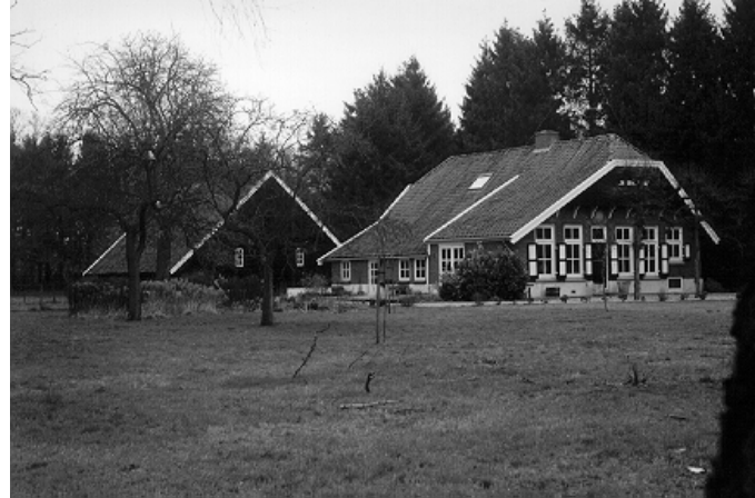
Oorspronkelijke Halle-boerderij omgebouwd tot burgerwoning
