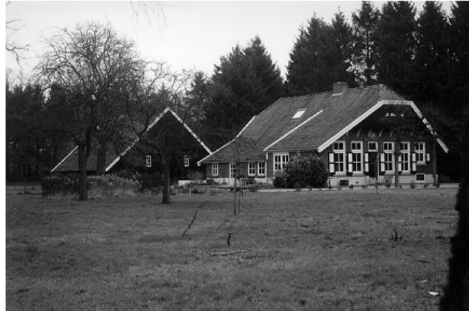
Oorspronkelijke Halle-boerderij omgebouwd tot burgerwoning
