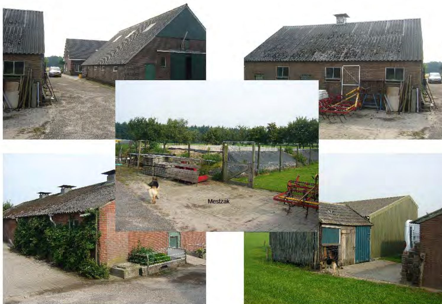
Foto's van de af te breken schuren en te verwijderen mestzak
