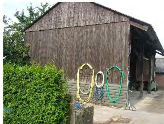
Bestaande hooischuur, gebouw in de jaren zeventig, kan blijven staan indien deze landschappelijk wordt ingepast. - Vervangen van de asbesthoudende dakplaten en vervangen voor asbestvrije dakplaten. - De gehele schuur ca 1 m. lager maken en geheel of gedeeltelijk dichtmaken met deuren, hierdoor wordt aangepast bij de bestaande woning
