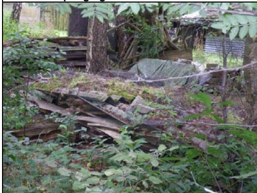
Foto B4.3 Schuur met asbest
