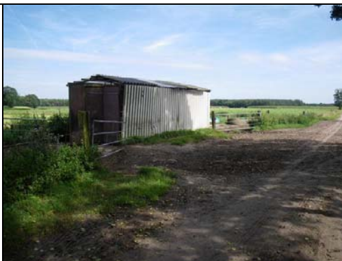
Foto B4.13 Melkschuur met asbestdak
