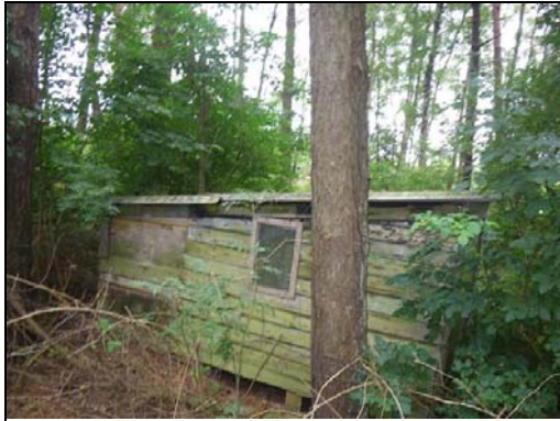
Foto B4.7 Schuur met asbestdak
