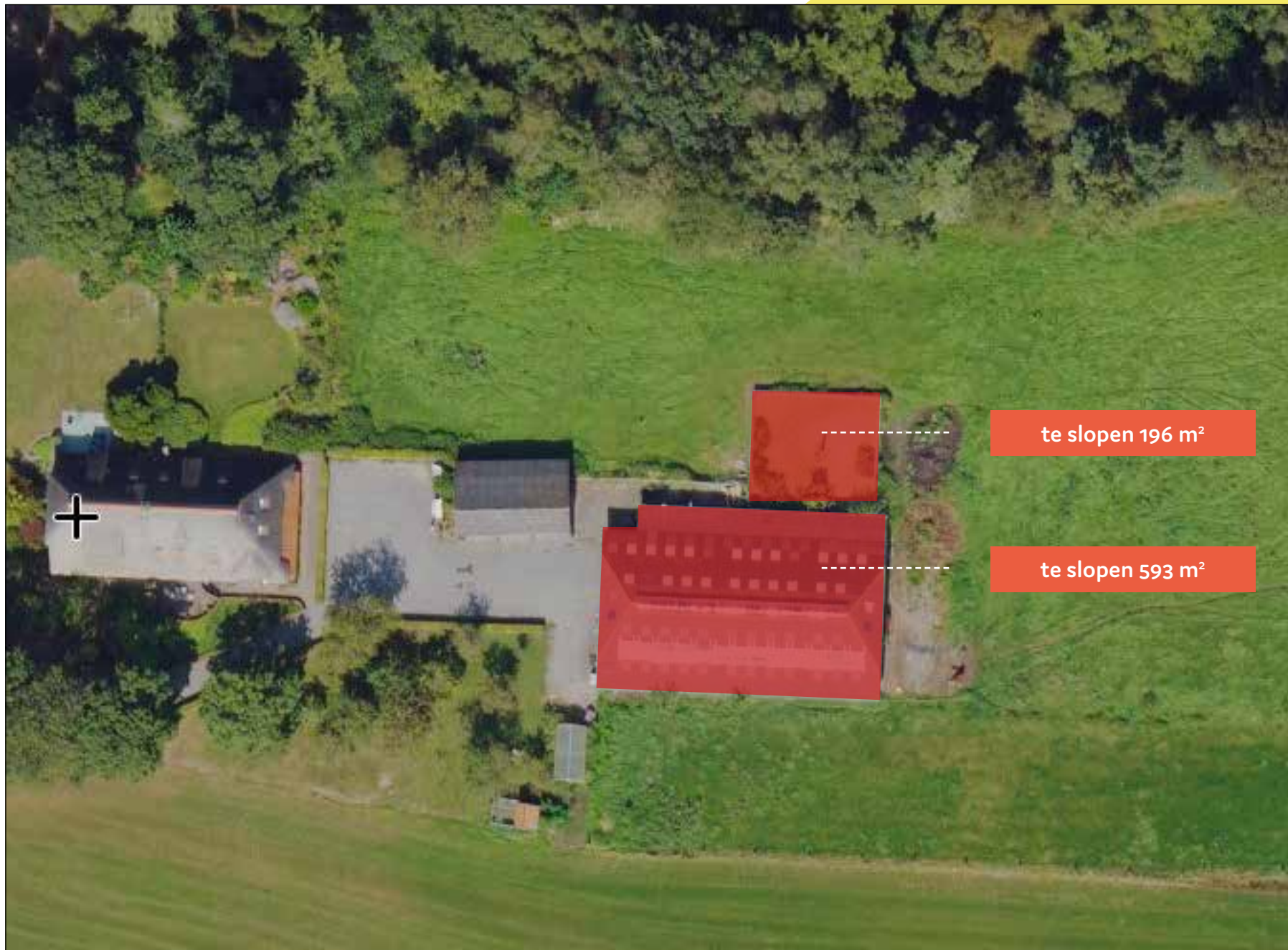
Te slopen oppervlak Vleugelweg 5
