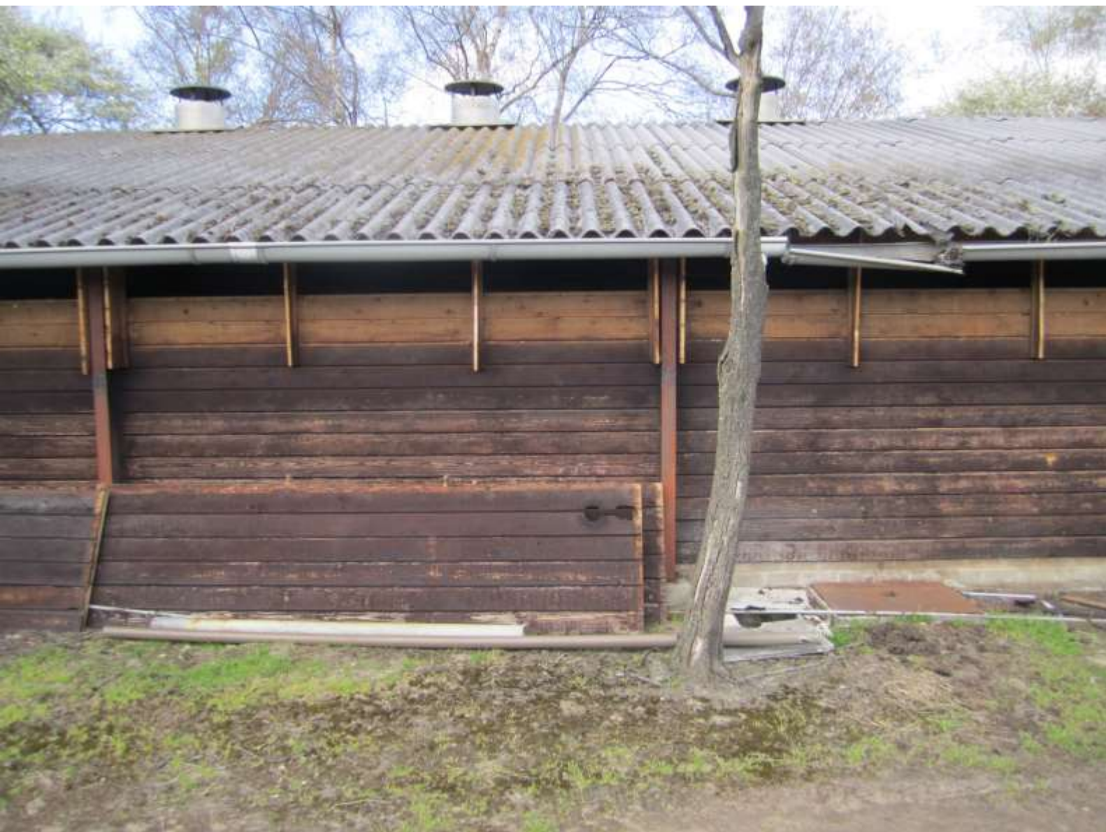
Foto 7. Eén van de af te breken schuren. Let op de grote opening onder de dakrand.
