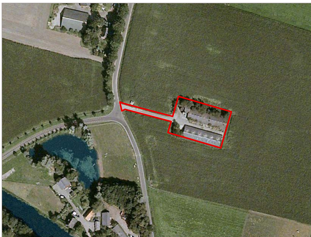
Afbeelding 14. Luchtfoto slooplocatie Hancateweg Oost 10
