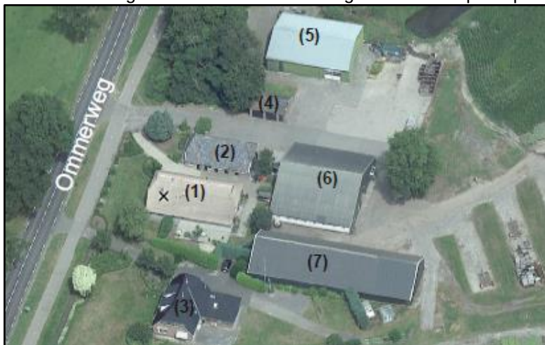
Figuur 5. Te slopen opstallen, nummer 4, 5, 6 en 7. Bron: Eelerwoude, 2018
