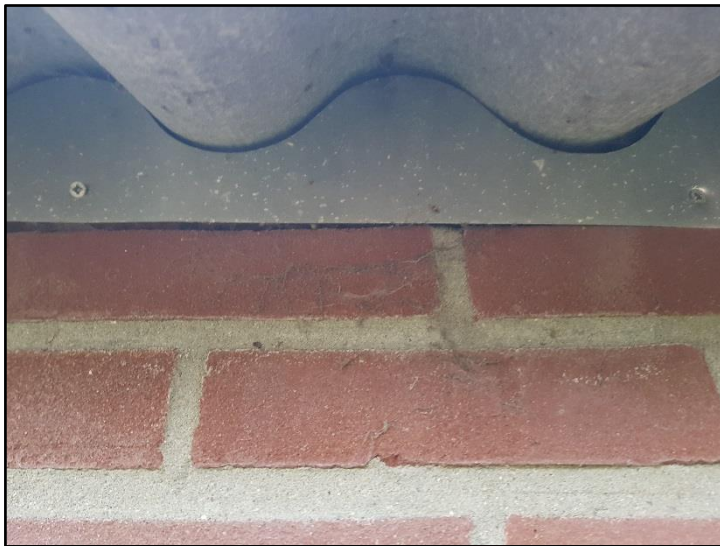
Figuur 5. Afdichting van het asbestdak van opstal nummer 4.
