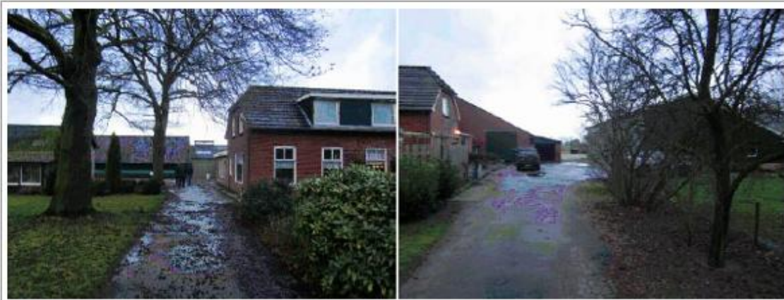
Figuur 3.3: Foto's van de twee huidige in- en uitritten (Bron: Eve architecten)
