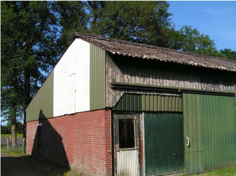
Afbeelding 5. Een van de schuren. Muur heeft geen spouw en de metalen platen zijn niet tegen een muur geplaatst.
