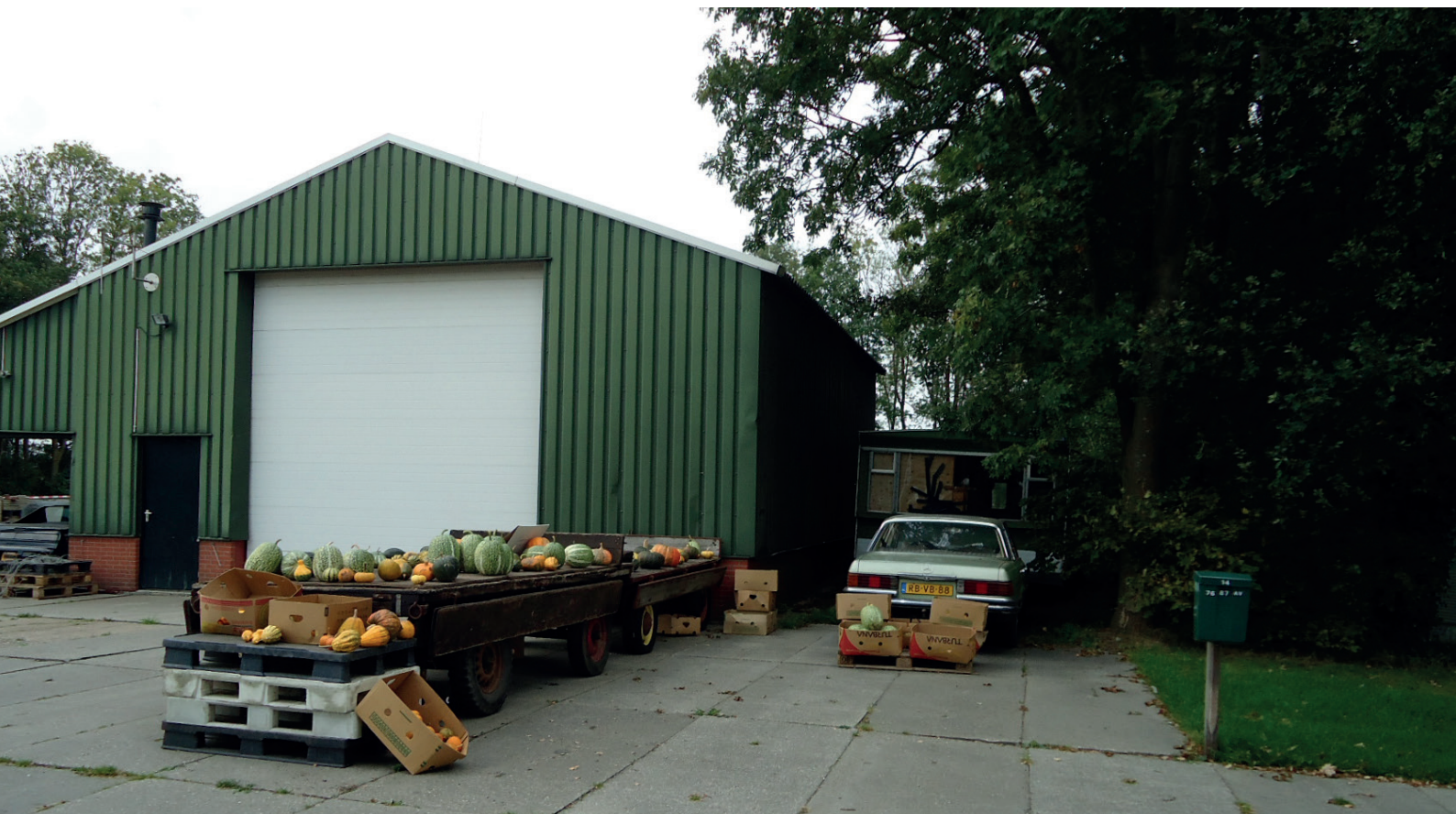
Afbeelding 3. Te verplaatsen schuur
