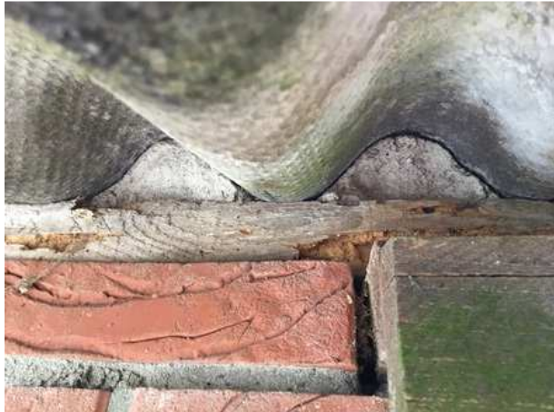
Afgedichte nokken van golfplaten. Hierdoor kunnen grondgebonden zoogdieren, zoals bruine rat en steenmarter, geen verblijfplaats bezetten onder de golfplaten.
