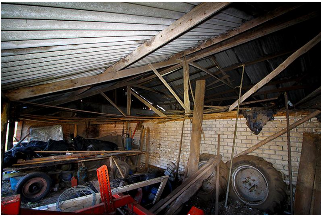
Planlocatie B schuur binnenzijde
