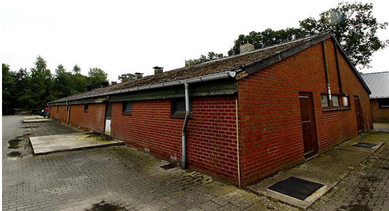
Afbeelding 10: De te slopen schuur aan de Lage Esweg
