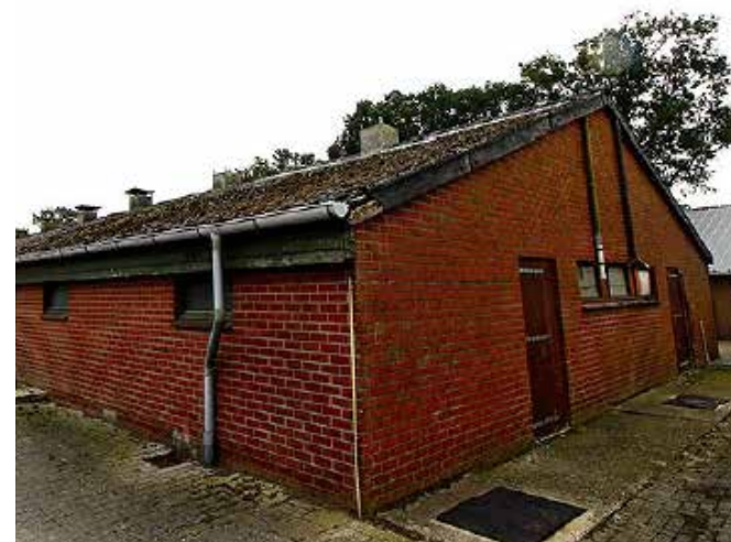
te slopen stal Lage Esweg
