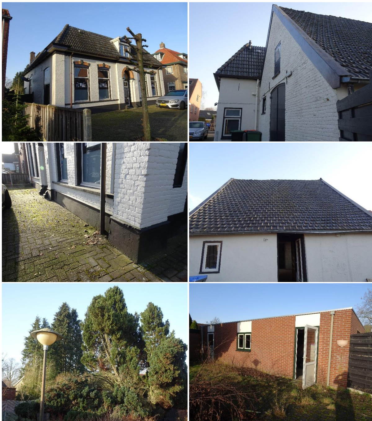
Figuur 1 Actuele situatie aan de Wilhelminastraat 58 te Nijverdal. Boven: Hoofdgebouw gezien vanaf de voor- en achterzijde. Midden: Afwezigheid van roosters en/of open stootvoegen in de gevel (links) en schuur achter het hoofdgebouw (rechts). Onder: achterzijde van het perceel met enkele bomen (links, de meeste bomen horen bij het belendende perceel erachter) en de garage (rechts). Foto's: Bureau Biota.
