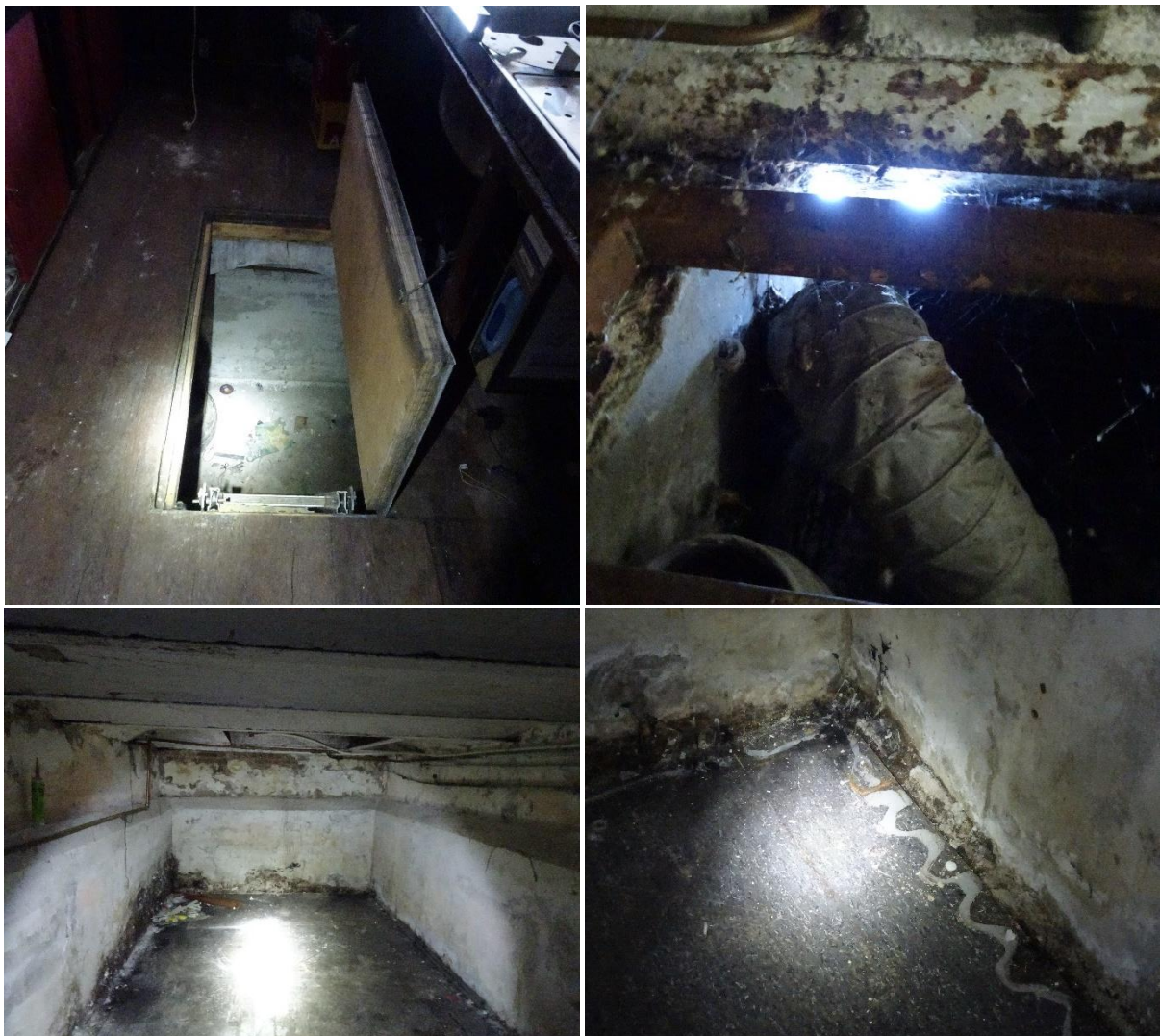
Figuur 6 Actuele situatie in de kelder onder het hoofdgebouw van de Wilhelminastraat 58 te Nijverdal. Er is van buiten, via een rooster, slechts één toegang waar vleermuizen gebruik van zouden kunnen maken. De kelder is volledig leeg en vrij van prooiresten of vleermuis-uitwerpselen. Er zijn dus geen aanwijzingen gevonden dat deze kelder in gebruik is bij vleermuizen of andere beschermde soort(groep)en. Foto's: Bureau Biota.
