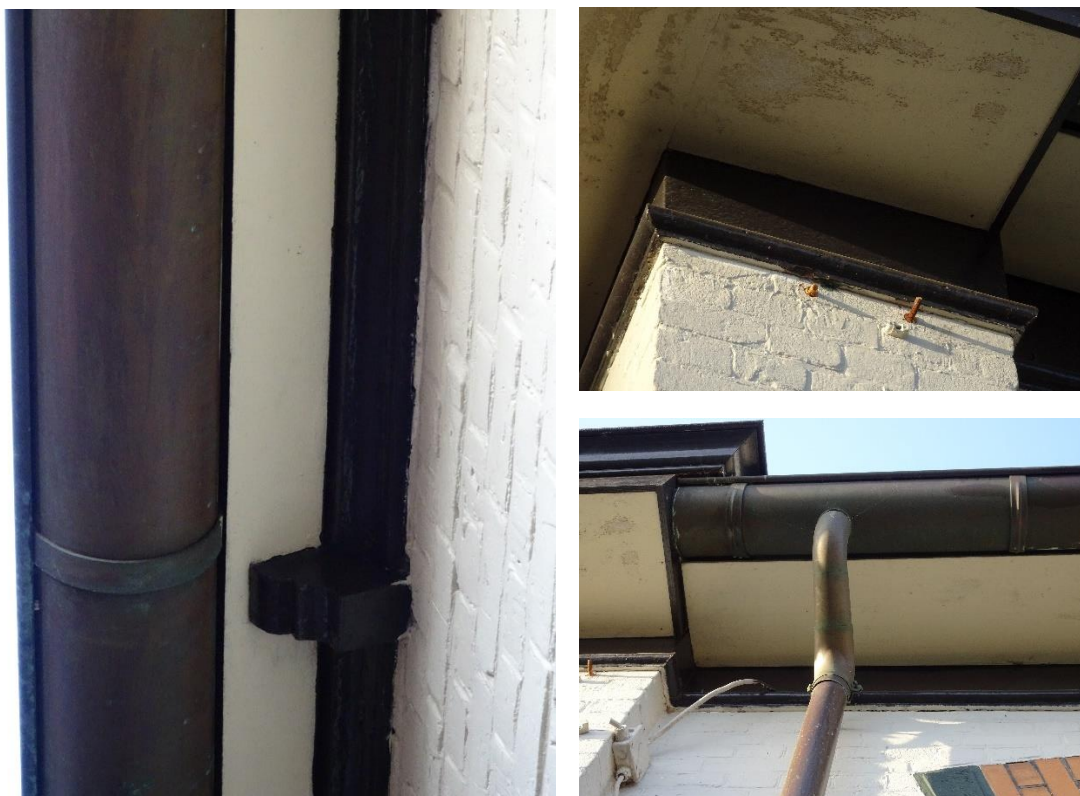
Figuur 3 Hermetisch afgesloten overgangen van gevel naar dak rondom het hoofdgebouw aan de Wilhelminastraat 58 te Nijverdal. Foto's: Bureau Biota.
