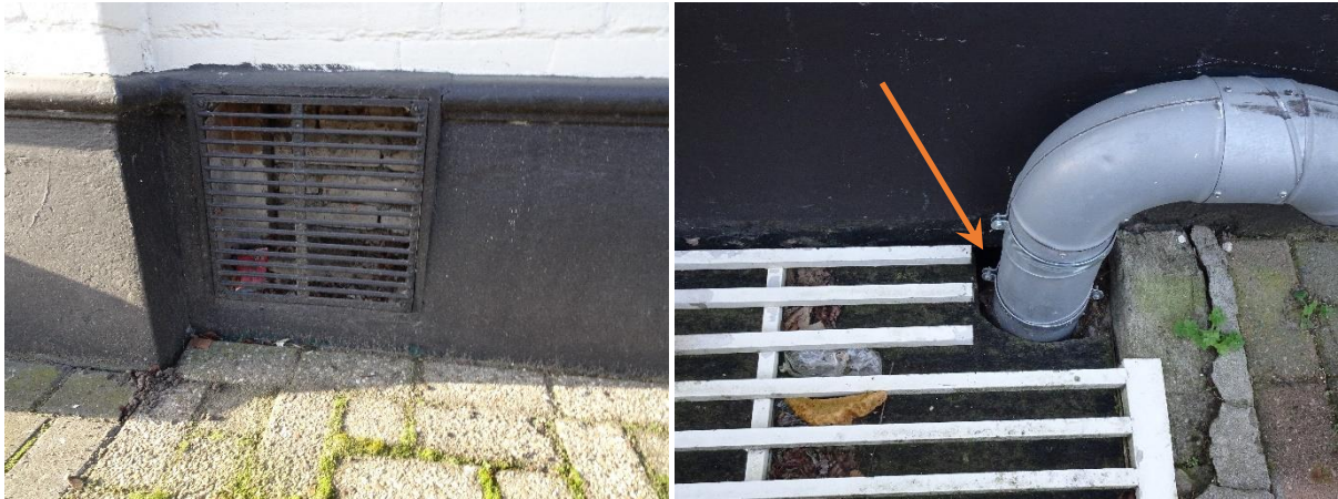
Figuur 5 Rondom het hoofdgebouw zijn twee roosters aangetroffen. Eén is aan de binnenzijde geblokkeerd met een bakstenen wand (zie linker foto). Het andere rooster geeft toegang tot de kelder (zie pijl rechter foto). Voor een impressie van de binnenzijde van de kelder, zie Figuur 6. Foto's: Bureau Biota.
