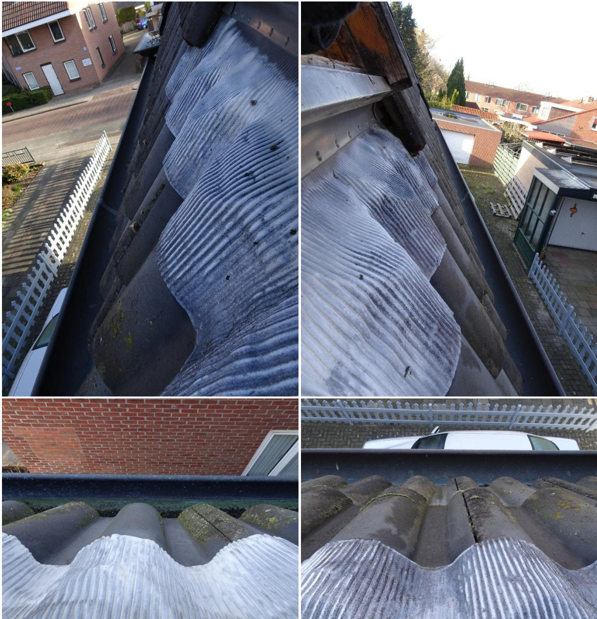
Figuur 12 Voorbeelden van de actuele situatie ter hoogte van het pannendak van het hoofdgebouw. De pannen en loodslabben sluiten goed op elkaar aan en geven geen ruimte voor gierzwaluwen om naar een nestplaats te kruipen. Voor huismussen is dit dak naar verwachting te steil (zie ook Figuur 1) om nesten te realiseren onder/achter de dakpannen. Foto's: Bureau Biota.
