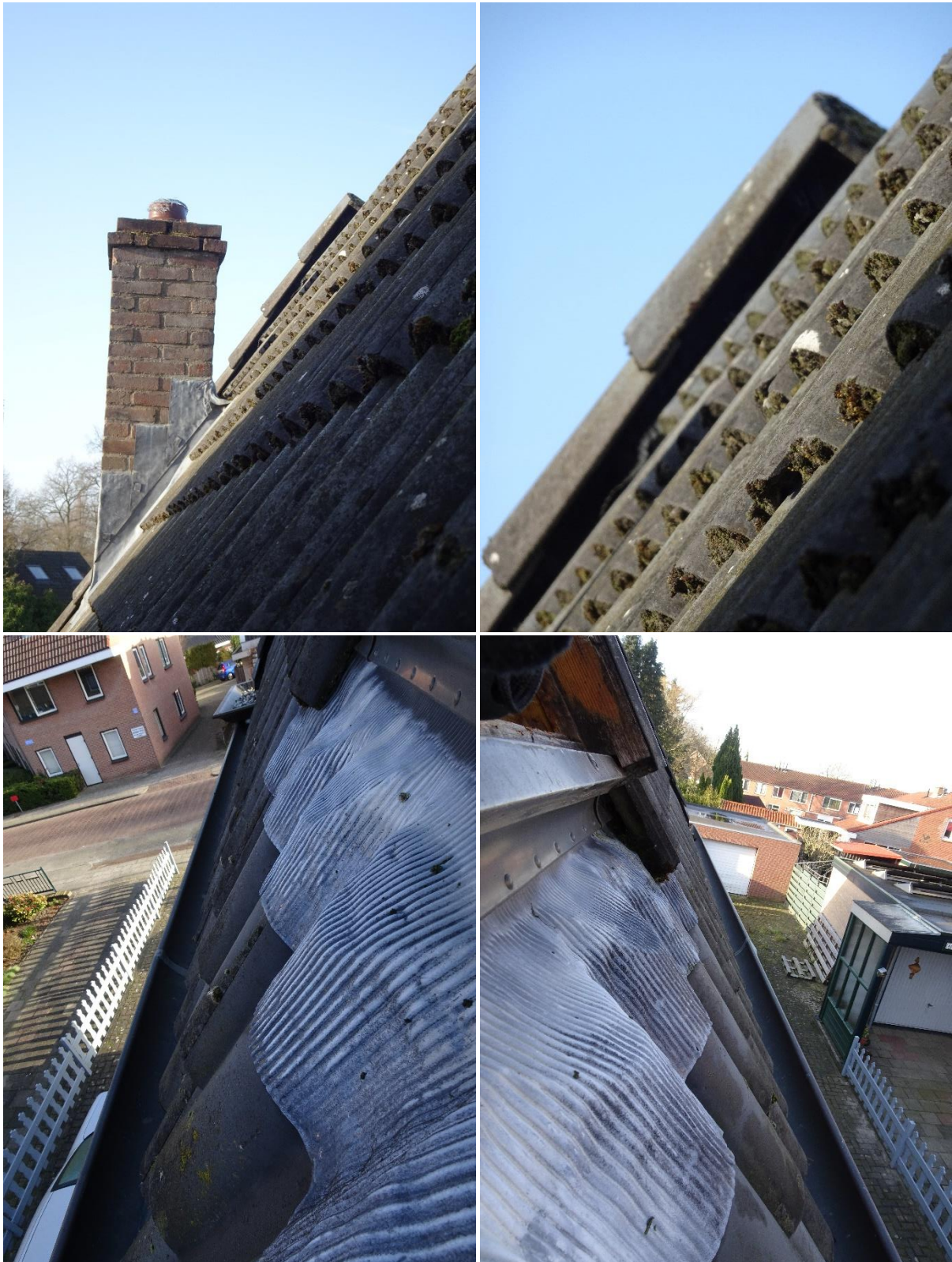
Figuur 4 Detail van de staat van onderhoud van het dak van het hoofdgebouw aan de Wilhelminastraat 58 te Nijverdal. Alle loodslabben zijn netjes aangesloten en de pannen liggen allemaal recht en strak tegen elkaar aan. Onder de nokken is ook alles goed afgedicht zodat er geen wegkruipmogelijkheden voor vleermuizen zijn. Foto's: Bureau Biota.
