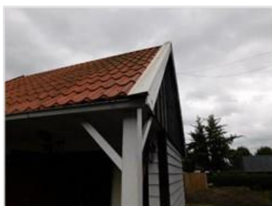
Figuur 2.4 Noordelijke schuur met kunststof dakbedekking.
