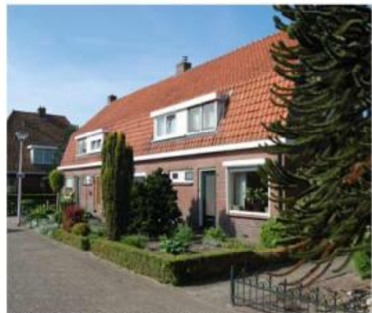
Ensemble rijenwoningen Julianastraat
