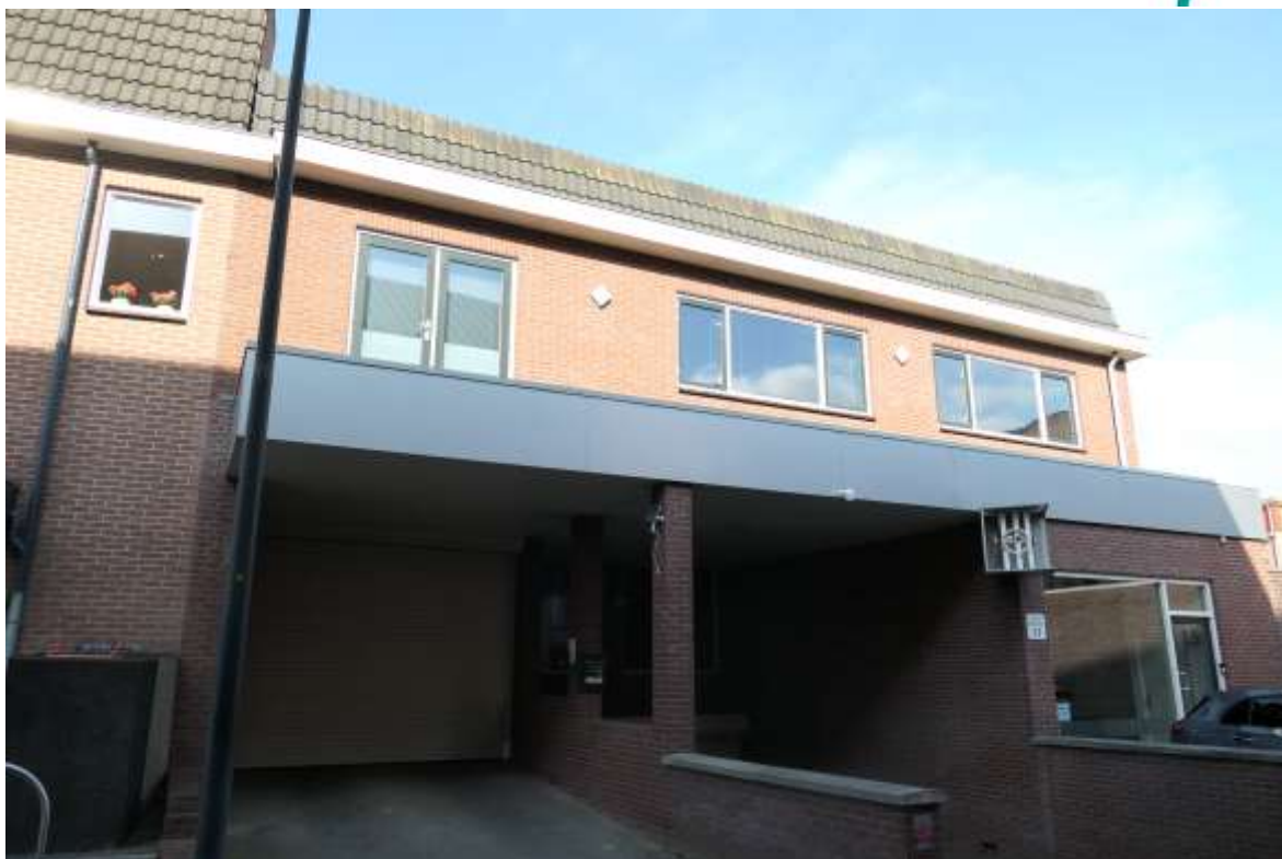
Afbeelding 2.2 Pand ter plaatse van Achter de Keizer 15.
