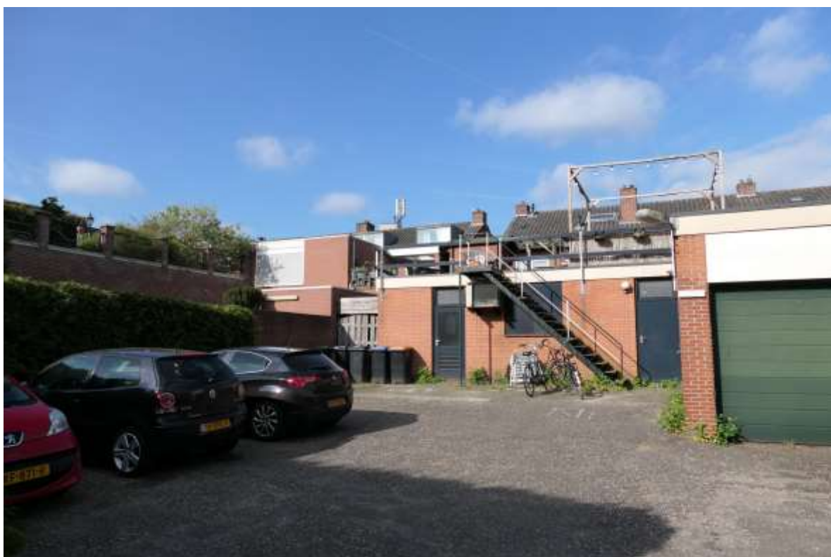
Afbeelding 2.5 Achterzijde panden behorende tot het plangebied.
