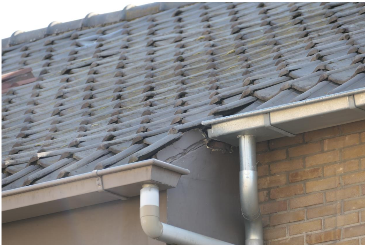
Figuur 4.3 Voor huismus is er toegang tot onder de eerste rij dakpannen en scheefliggende dakpannen. Zwarte roodstaart (categorie 5 vogelsoort) kan onder scheefliggende dakpannen tot broeden komen.
