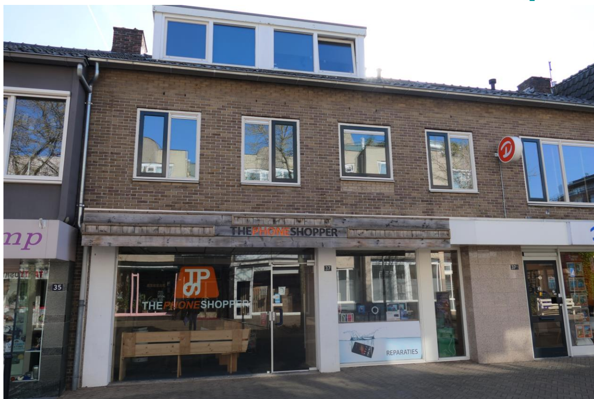
Figuur 1.3 Winkelpand en bovenwoning ter plaatse van Keizerserf 37 en 37a.
