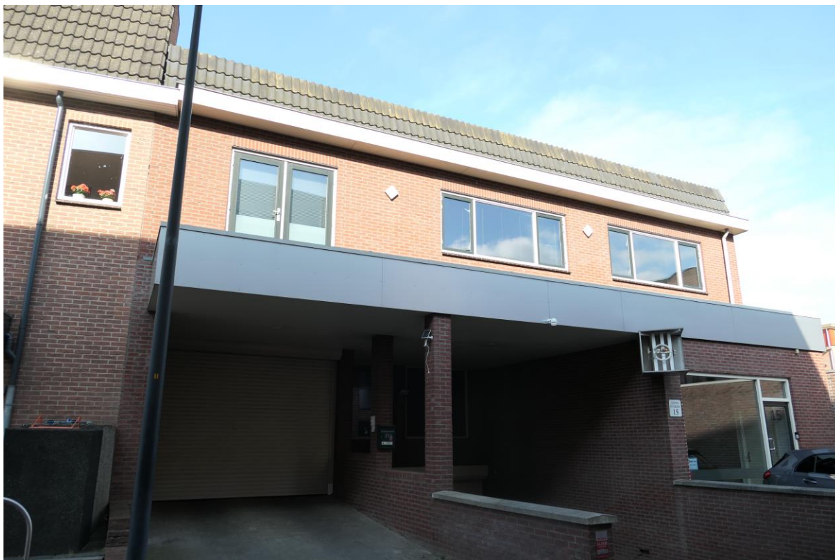
Figuur 1.5 pand ter plaatse van Achter de keizer 15.
