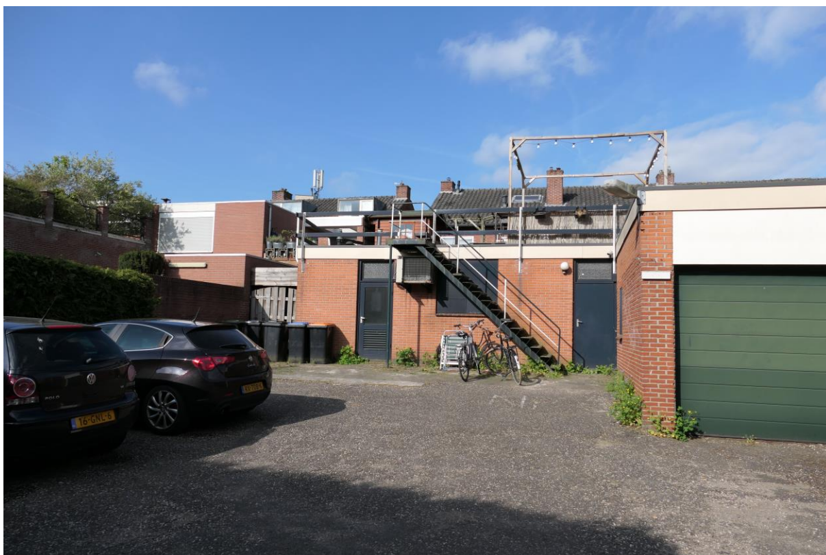
Figuur 1.6: Achterzijde panden behorende tot het plangebied.
