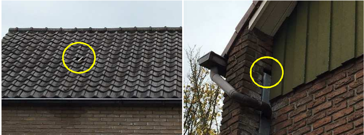
Gaten in het dakvlak en zijgevel. Deze gaten vormen mogelijke nestplaatsen voor vogels.
