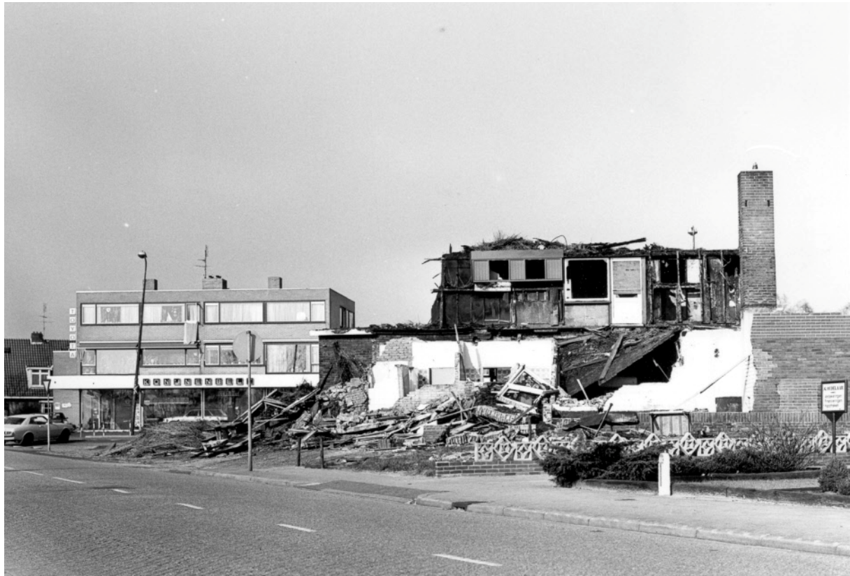
Afb 4; Foto van de voormalige bebouwing van Cafe Oudlaer in het plangebied. De foto is genomen tijdens de sloopwerkzaamheden na de brand in 1980.
