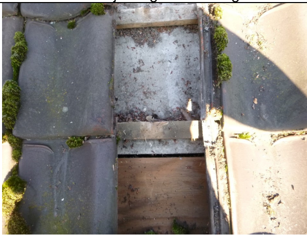
Foto 24: gedeelte van woning nr. 118 heeft houten dakbeschot.
