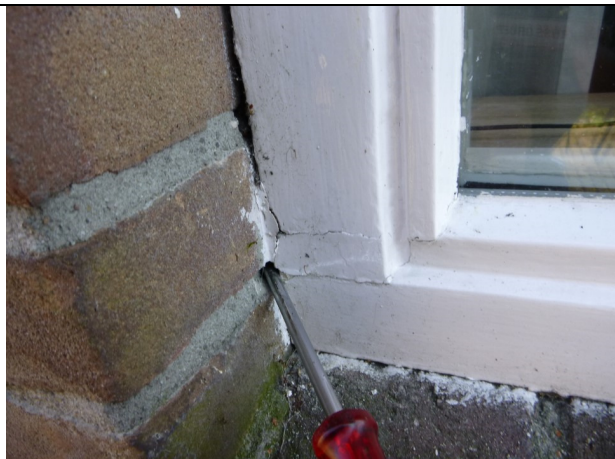
Foto 23: inspectie in spouw.
