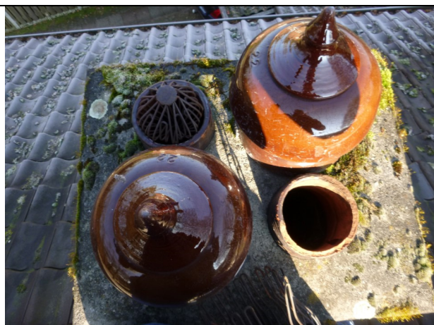
Foto 16: bovenzijde ingemetselde gresbuis.
