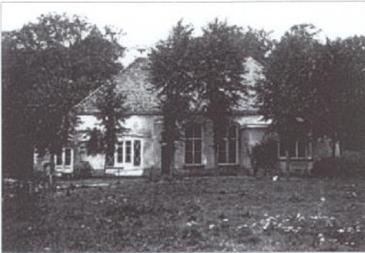
Afb. 2.20: De zuidgevel van de Eversberg, na de aanbouw van de serre, foto, ca. 1905. (Herkomst: J. Bouwmeester)
