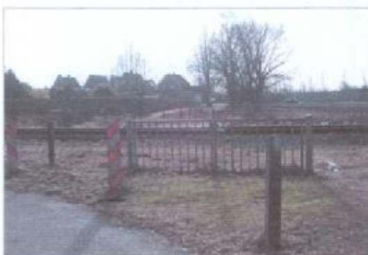
Afb. 1.5: De oude oprijlaan is afgesneden door het spoortracé Zwolle-Almelo. (Foto: SB4, 2003)
