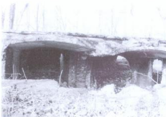
Afb. 2.44: De ruïne van De Eversberg voor de herstelwerkzaamheden, ca. 1980. (Foto: B. Olde Meierink, 1980)
