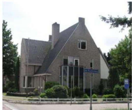
Afwijkend kleur- en materiaalgebruik
