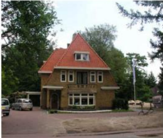
Samengestelde hoofdvorm met een fors zadeldak. Details in vorm van erker/ balkon. Geel metselwerk, rode pannen,
