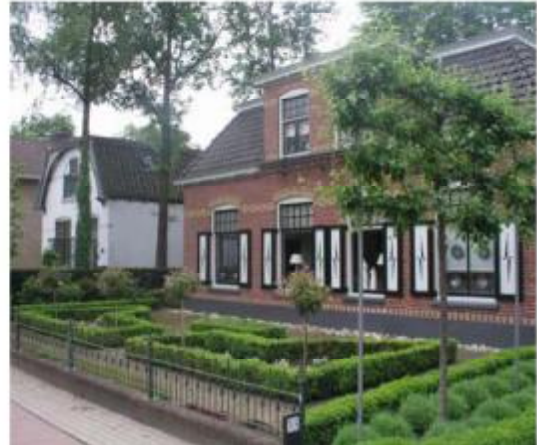
Eenvoudige hoofdvorm met zadeldak. Details in metselwerk, luiken. Roodmetselwerk antraciet pannendak.
