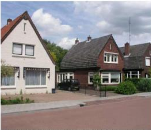
Ensemble vrijstaande woningen noordzijde Van Limburg Stirumstraat
