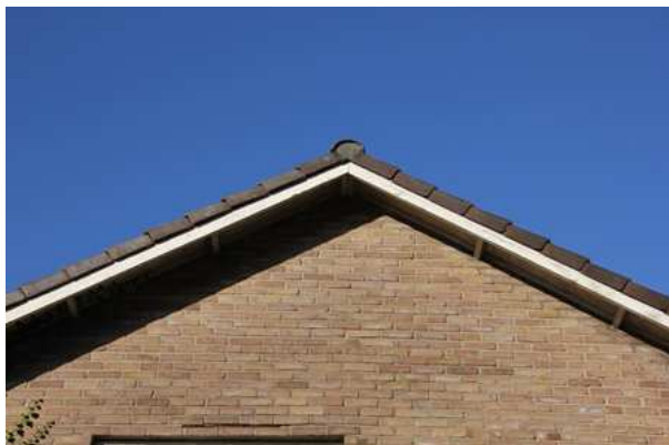
Gevelpannen met overstek. Dit zijn potentiële zomerverblijfplaatsen van dwergvleermuizen.
