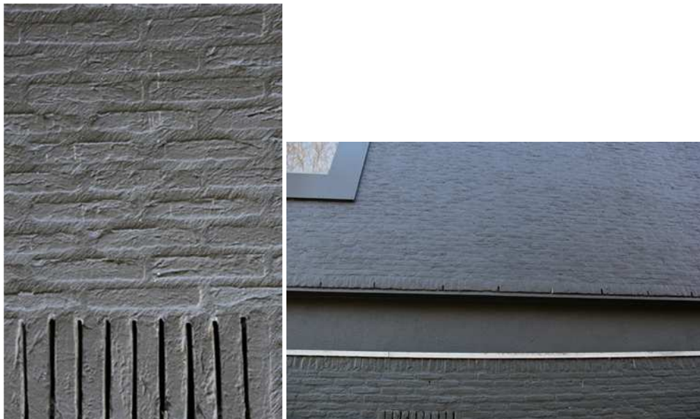
Kleine openingen in het buitenblad. Deze openingen geven vleermuizen mogelijk toegang tot de holle spouw.
