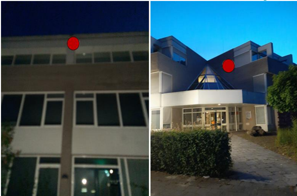
Figuur 4.2 Vastgestelde zomerverblijfplaatsen gewone dwergvleermuis (zie ook fig 4.1). Links: de noordelijke verblijfplaats met invliegopening aan de dakrand. Rechts: de meest zuidelijke verblijfplaats boven de entree, invliegopening onduidelijk (dakrand, open stootvoeg of ruimte tussen kozijn).
