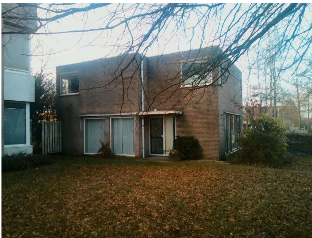
Figuur 2.3 Zuidzijde te slopen woning Nicolaas Beetsstraat 8.
