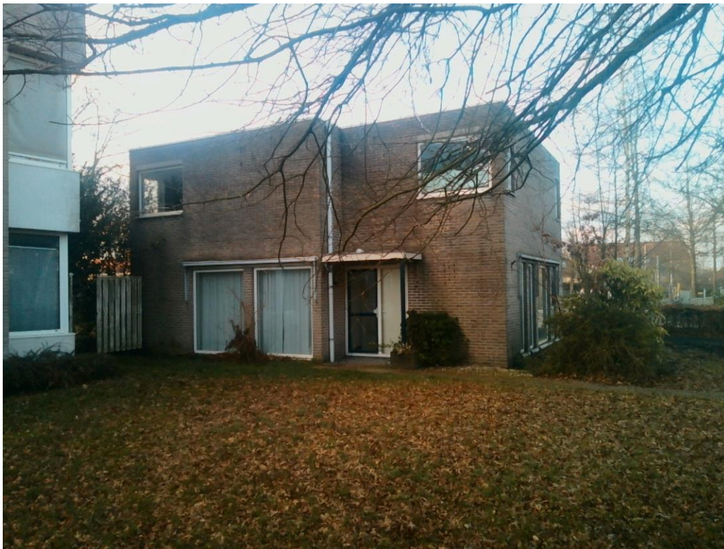
Figuur 2.5. Zuidzijde te slopen woning Nicolaas Beetsstraat 8.
