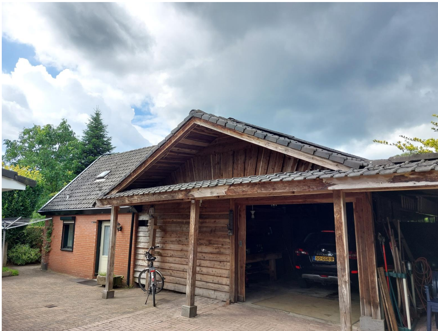
Figuur 4: Zicht vanaf het perceel op de schuur met de aangrenzende woning, situatie op 19 juli 2023.
