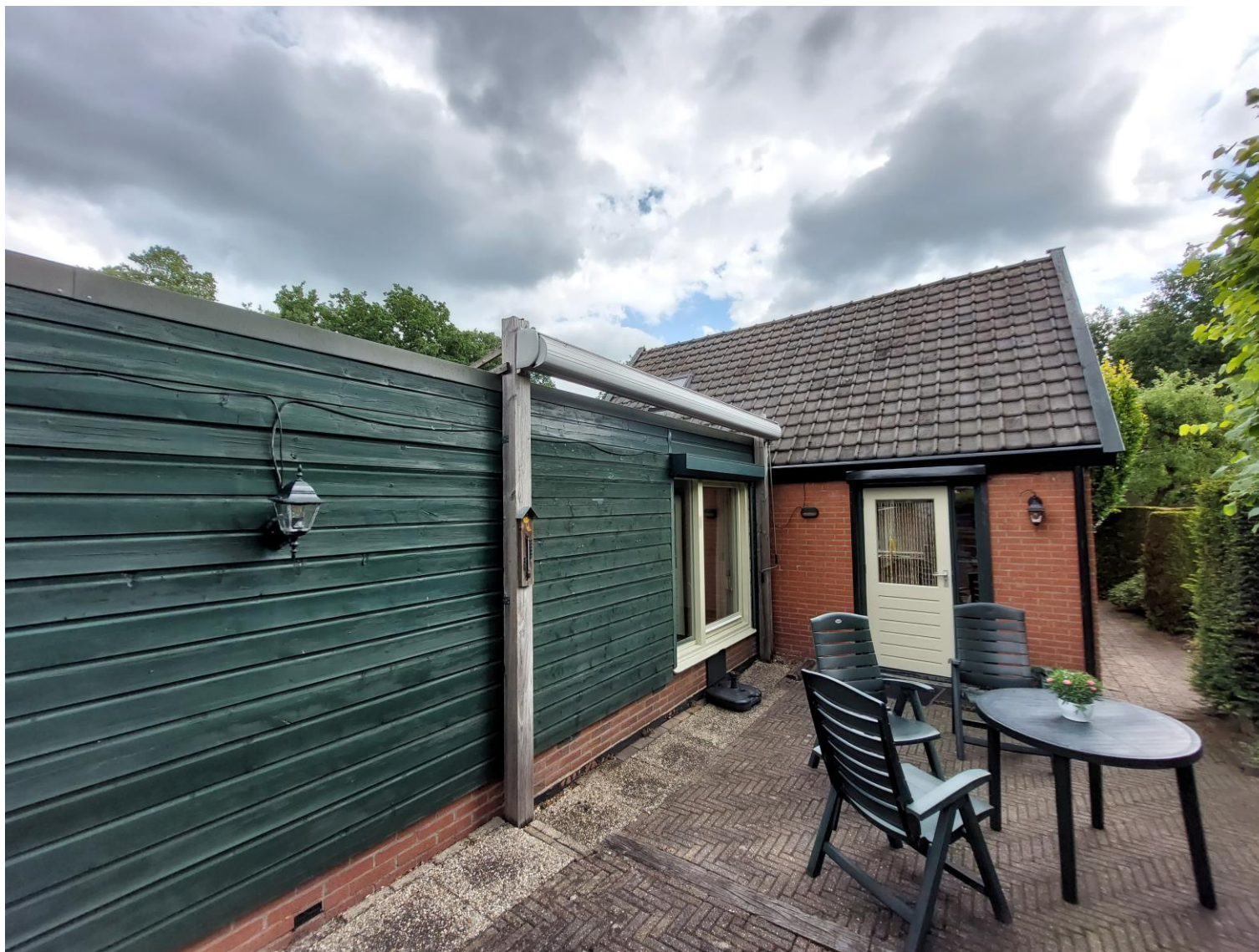
Figuur 5: Zicht vanaf het perceel op het bijgebouw naast de woning, situatie op 19 juli 2023.
