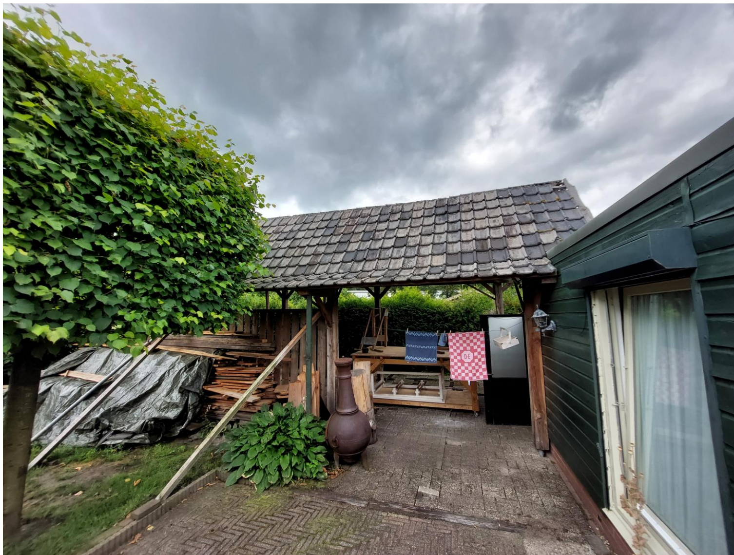
Figuur 6: Zicht vanaf het perceel op het bouwwerk dat fungeert als overkapping voor de camper van de eigenaar en op één van de drie leilindes, situatie op 19 juli 2023.
