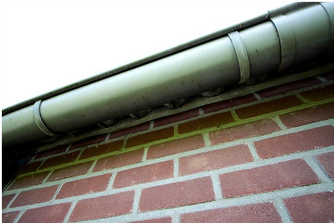
Planlocatie A afwerking met golfprofiel
