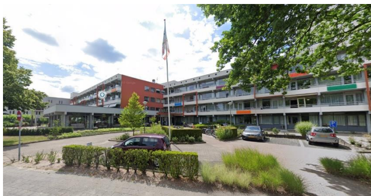
Figuur 12: Zorgcentrum de Blenke met plat dak
