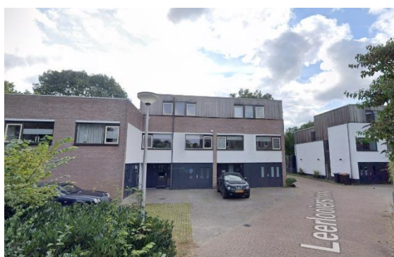
Figuur 13: Leerlooierstraat 29 t/m 23 met plat dak
