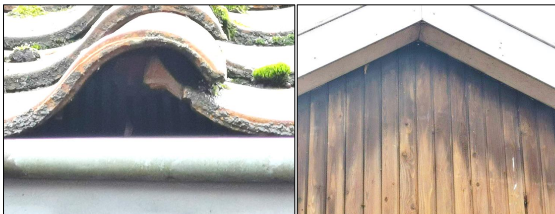
Figuur 6.1 (links): Impressie van de aangebrachte vogelschroot onder de pannendaken van de bebouwing; Figuur 6.2 (rechts): Impressie van een van de boeiboorden, welke strak aansluit aan de gevel en niet beschikt over kieren, gaten of overhangende dakpannen.
