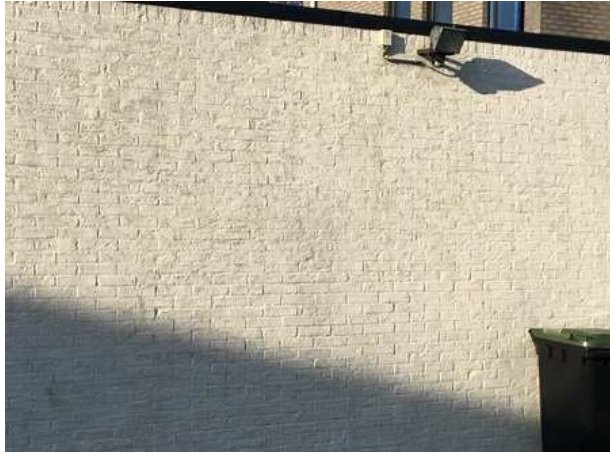
Buitenmuur van één van de gebouwen in het plangebied. In de buitenmuur zijn geen openingen, zoals open stootvoegen of ventilatieopeningen zichtbaar.
