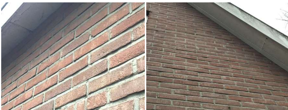
Hoogwaardige afwerking. De dakbetimmering sluit nauw aan op de buitengevel waardoor vleermuizen de spouw niet kunnen benutten als verblijfplaats.
