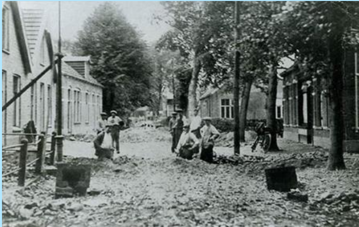
Afbeelding 2.1, aanleg riolering Dorpsstraat in Hellendoorn, ter hoogte van Bakker Ronhaar.
