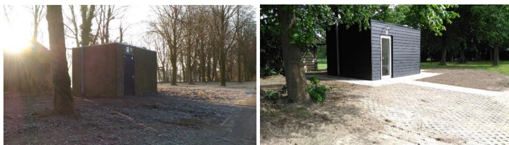
Afbeelding 2.3, gemaal Kerkstraat voor en na de renovatie
