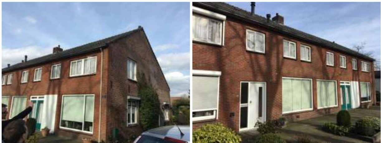
Detailopname van de te slopen bebouwing.
