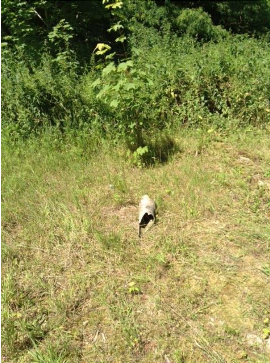
Foto 2: asbest verdachte afvoerpijp
